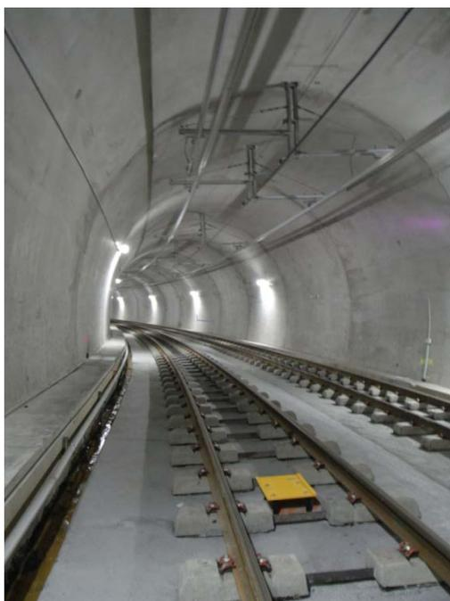
La electrificación de la Línea 2 del FMB está compuesta por catenaria rígida, este permite la electrificación de túneles con gálibo reducido, ya que se prescinde del cable sustentador y se utiliza un perfil de aluminio con la rigidez necesaria para sostener el hilo de contacto. Así mismo, y dada la sección de los perfiles aéreos de aluminio, se prescinde de los feeders de acompañamiento.
