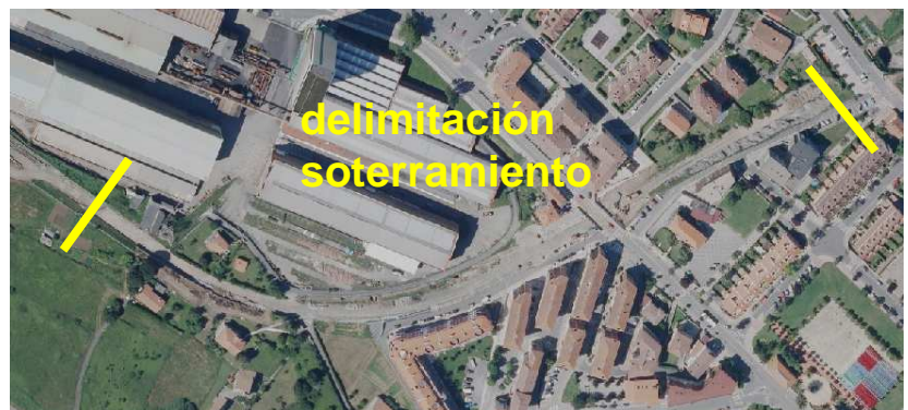
Ortofoto aérea de la zona. Fuente Geoeuskadi 2015 -Tramo de la estación en fase de soterramiento -
