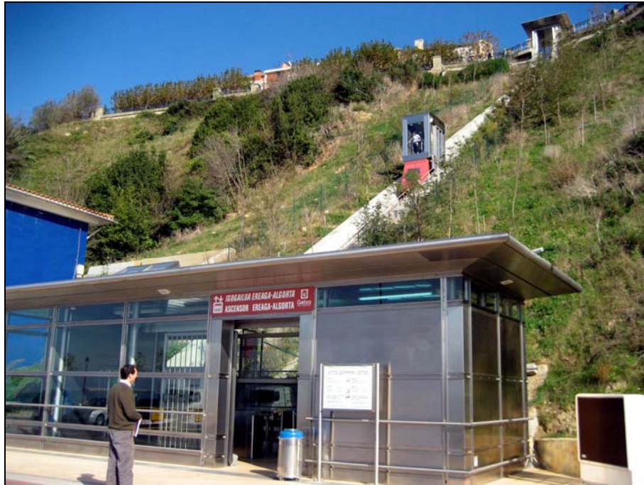
Ilustración: Ascensor y taquillas de Ereaga.
