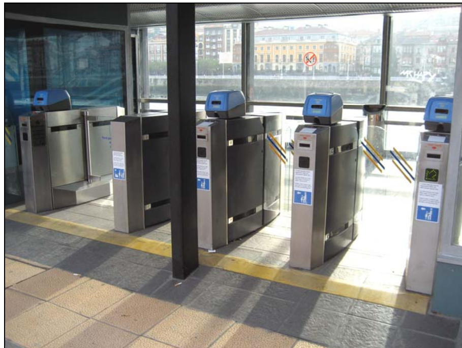
Ilustración: Línea de validación lado Getxo: Creditrans y Código de Barras.
