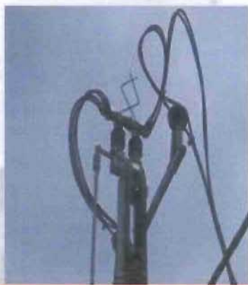
PARARRAYOS Y PUNTOS FIJOS EN SECC.
